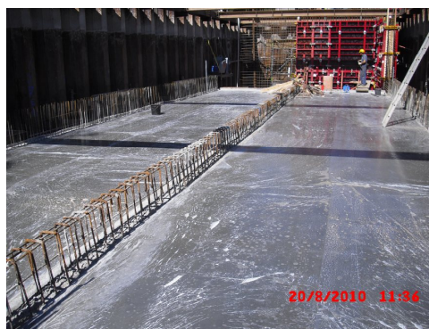
Betonierte Bodenplatte RÜB I
