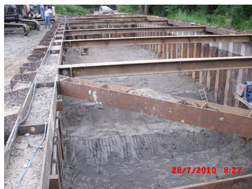
Gespundete Baugrube mit Weichgelsohle
